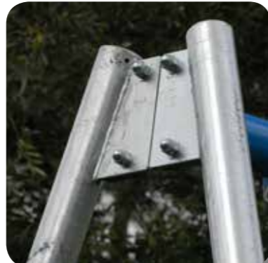
K&K Verbindung Schaukelstütze/Träger
